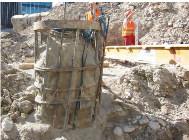
Bild 6 Verdrehter Pfahlkorb infolge Sandverfüllung bei Herstellung des Osterberg-Versuchspfahls
