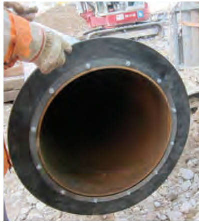
Bild 5 Ausbildung Hülse für einen Bohrpfahl (links: Stahlrohr mit 3 cm starker Luftpolsterfolienschiicht – Mitte: Gummilippe am Fuss Stahlrohr – rechts: Betonieren Hülsenpfahl)
