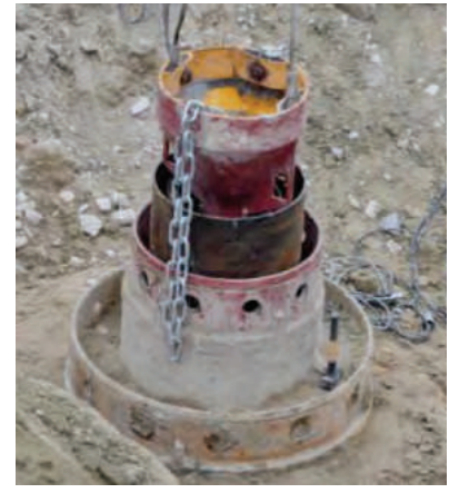
Bild 5 Ausbildung Hülse für einen Bohrpfahl (links: Stahlrohr mit 3 cm starker Luftpolsterfolienschiicht – Mitte: Gummilippe am Fuss Stahlrohr – rechts: Betonieren Hülsenpfahl)
