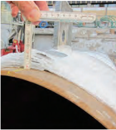
Bild 5 Ausbildung Hülse für einen Bohrpfahl (links: Stahlrohr mit 3 cm starker Luftpolsterfolienschiicht – Mitte: Gummilippe am Fuss Stahlrohr – rechts: Betonieren Hülsenpfahl)
