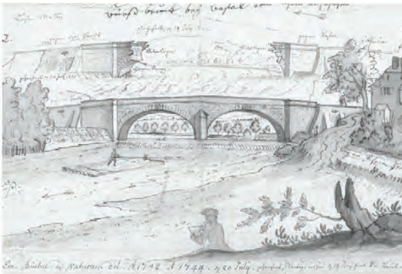
oben: eingestürzte Brücke (1744)
