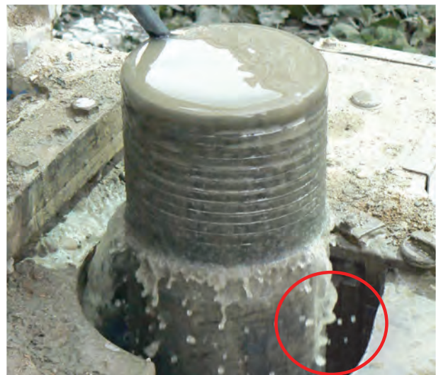
Bild 4 Spülvorgang bei Mikropfählen zur Sicherstellung einer freien Länge (links: Beginn Spülvorgang, austretendes Wasser trüb und zementhaltig, rechts: Wasser klar nach 5-10 Minuten spülen)
