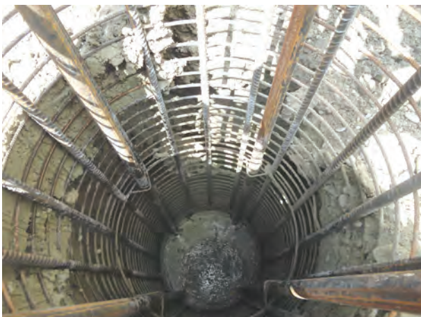
Bild 11 Bohrpfahl mit 4 Ultraschallmessrohren, nach Ziehen Verrohrung und vor Verfüllung mit Aushubmaterial (Pfahl mit Leerbohrung)
