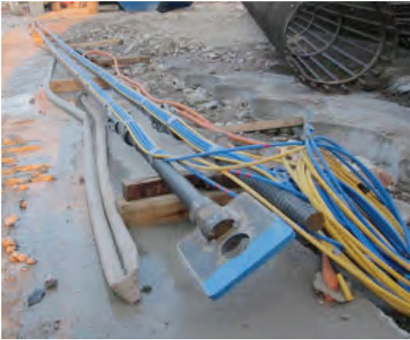
Bild 3 Versuchsmikropfahl (links: Mikropfahl mit Injektionsschläuchen (blau) und Freispülschläuchen (gelb) rechts: Detail Verankerungsstrecke mit Injektionsschläuchen)
