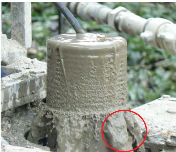
Bild 4 Spülvorgang bei Mikropfählen zur Sicherstellung einer freien Länge (links: Beginn Spülvorgang, austretendes Wasser trüb und zementhaltig, rechts: Wasser klar nach 5-10 Minuten spülen)
