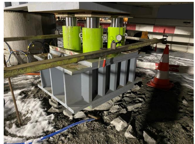
Abbildung 5-2: Feinmessuhr am Versuchspfahl zur Messung der Vertikalverschiebung.
