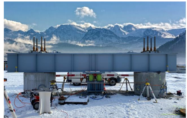
Abbildung 4-2: Traverse zur Lasteinleitung in die Reaktionspfähle. Oben: Planschnitt; Unten: Ausführung Baustelle.
